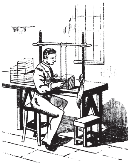
Рис. 70-й. Положеніе станка и работника при шиваніи.
