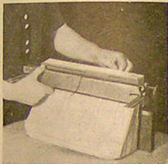
Рис. 74. Обработка блока в разборном переплетном ящике: слева — прокол блока дрелью, справа — сшивка блока
