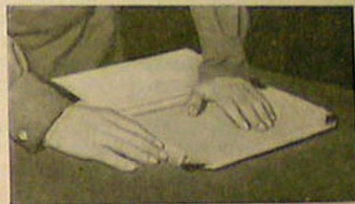
Рис. 40. Подгиб краев оклейки на внутреннюю сторону крышки
