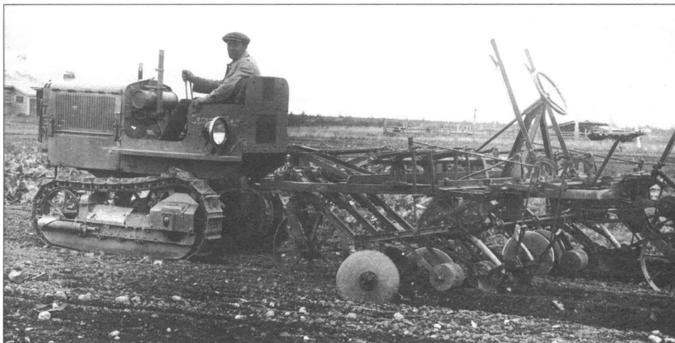
Опыт применения культиватора ВИМ-2 с трактором Caterpillar Ten
