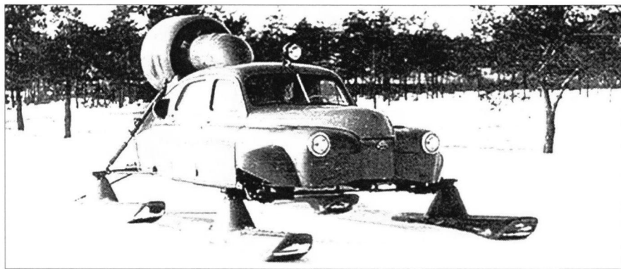
Справка «М-К». Аэросани «Север-2» были спроектированы в ОКБ Н.И. Камова в 1959 году и серийно выпускались с 1960 по 1961 год на заводе «Прогресс» (г. Арсеньев). Подробно о конструкции и эксплуатации этих машин, см. – И. Ювенальев «Победа» становится на лыжи» в журнале «Моделист-конструктор» №12/1979
