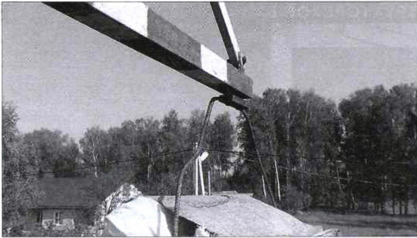
На короткую часть стрелы вешается корзина противовеса
