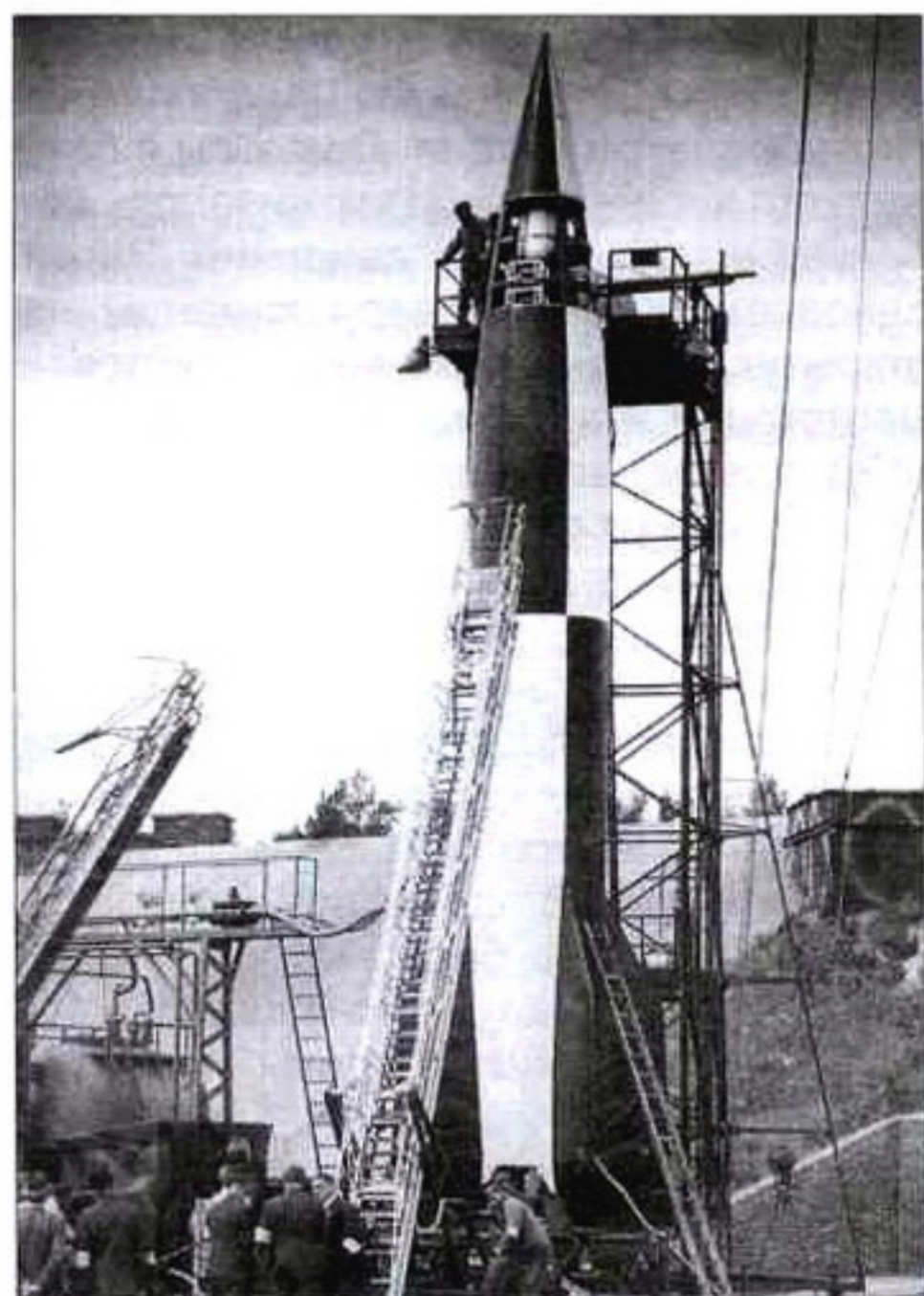
А-4 готовится к испытательному полету. Крышки приборного отсека сняты. Виден белый контейнер, в котором размещены приборы системы управления. Обратите внимание на множество гражданских специалистов, стоящих возле ракеты: не имеющие повязок не имеют права находиться на стартовой позиции
