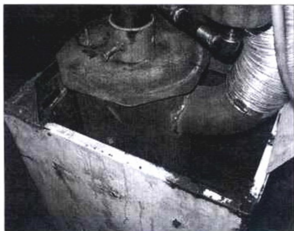
Вид на выхлопную трубу
