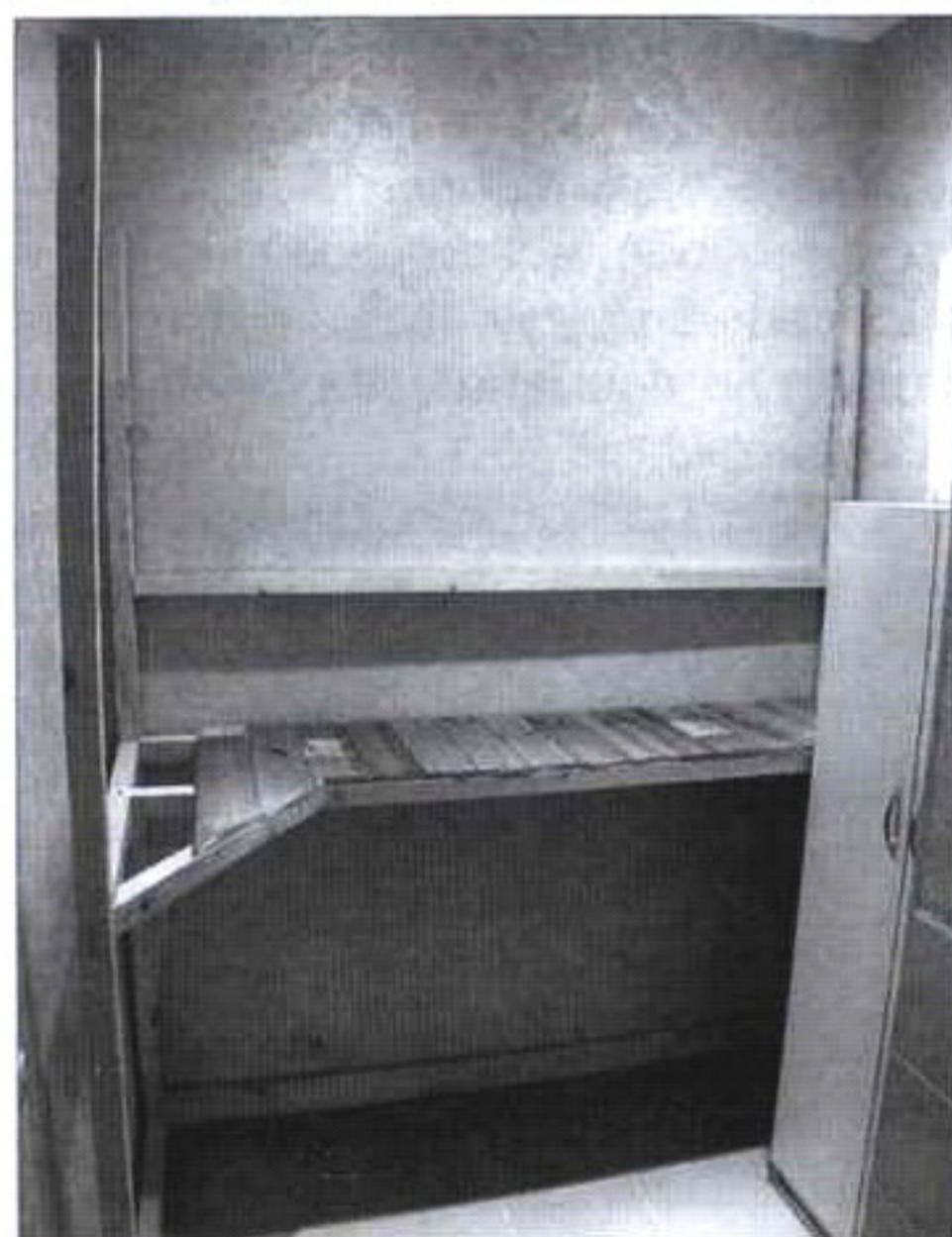
Нижняя полка стеллажа в процессе сборки в подсобном помещении
