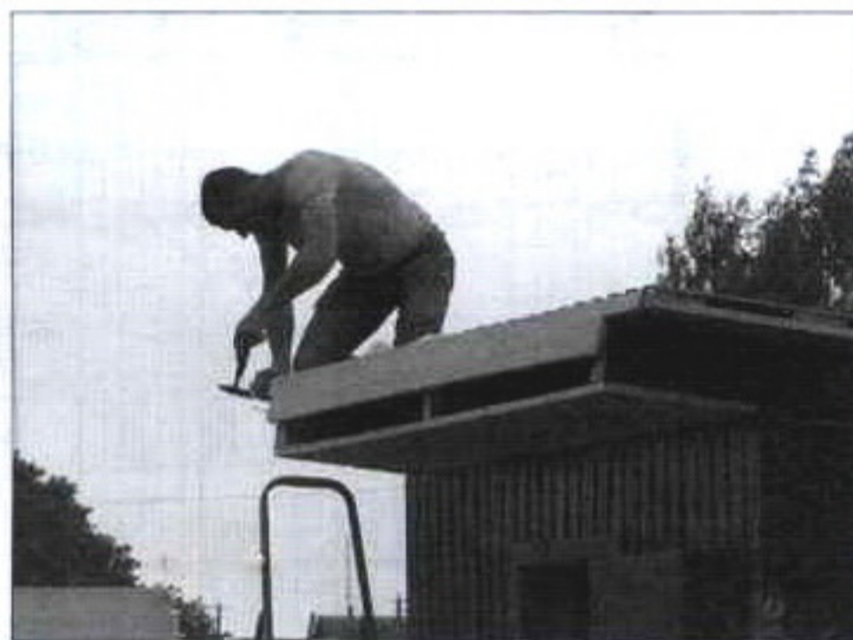
Последовательность изготовления свеса крыши со стороны фасада
