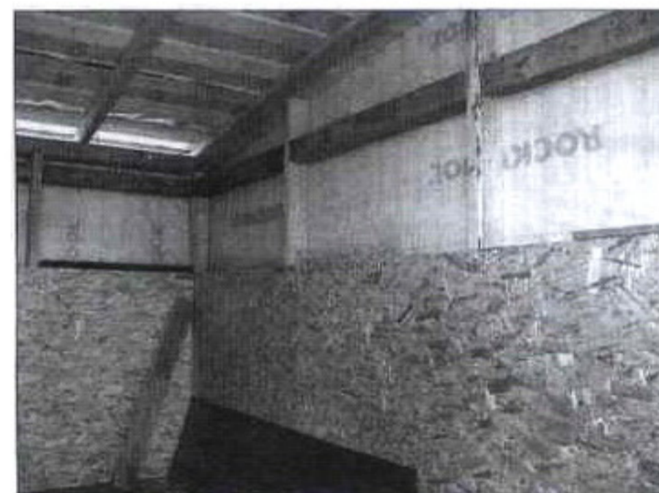
Обшивка стен панелями ОСП
