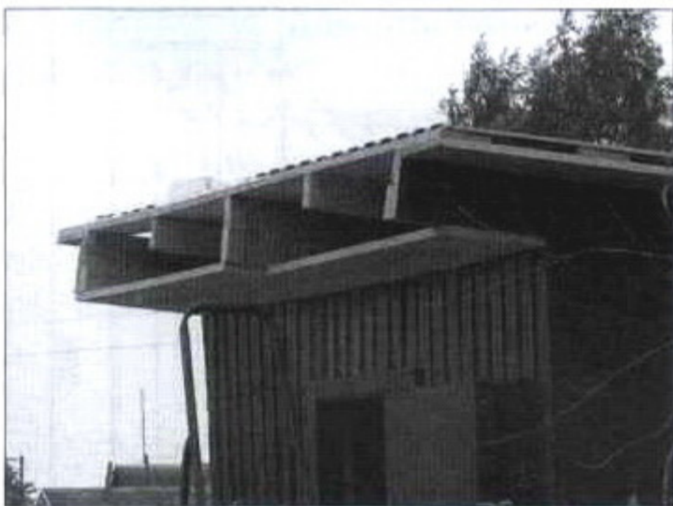
Последовательность изготовления свеса крыши со стороны фасада
