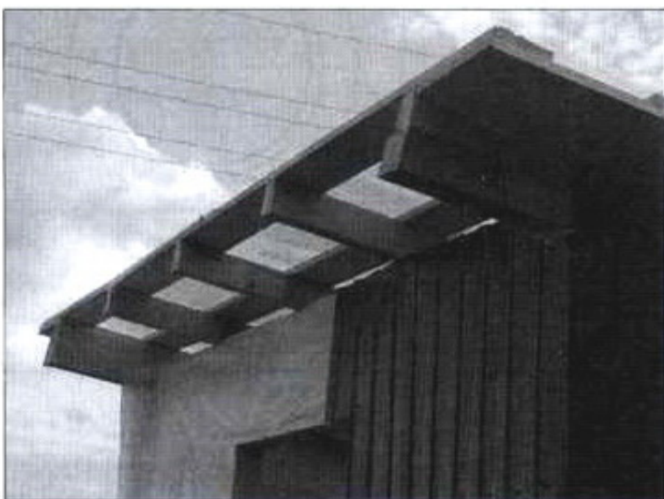
Каркас бокового свеса
