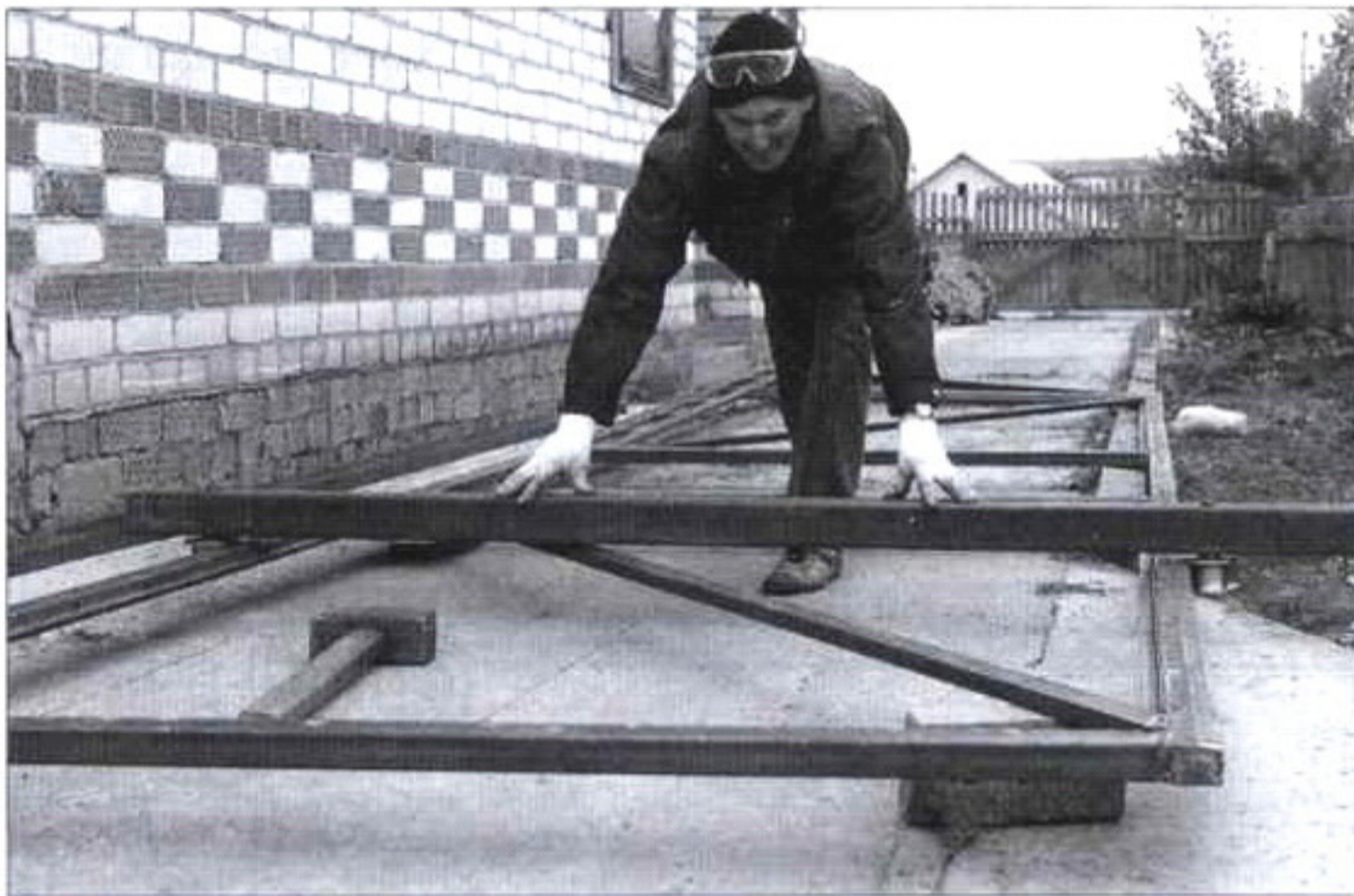
Проверка расположения на столбе «трубных» опорного и удерживающего роликов по высоте каркаса ворот
