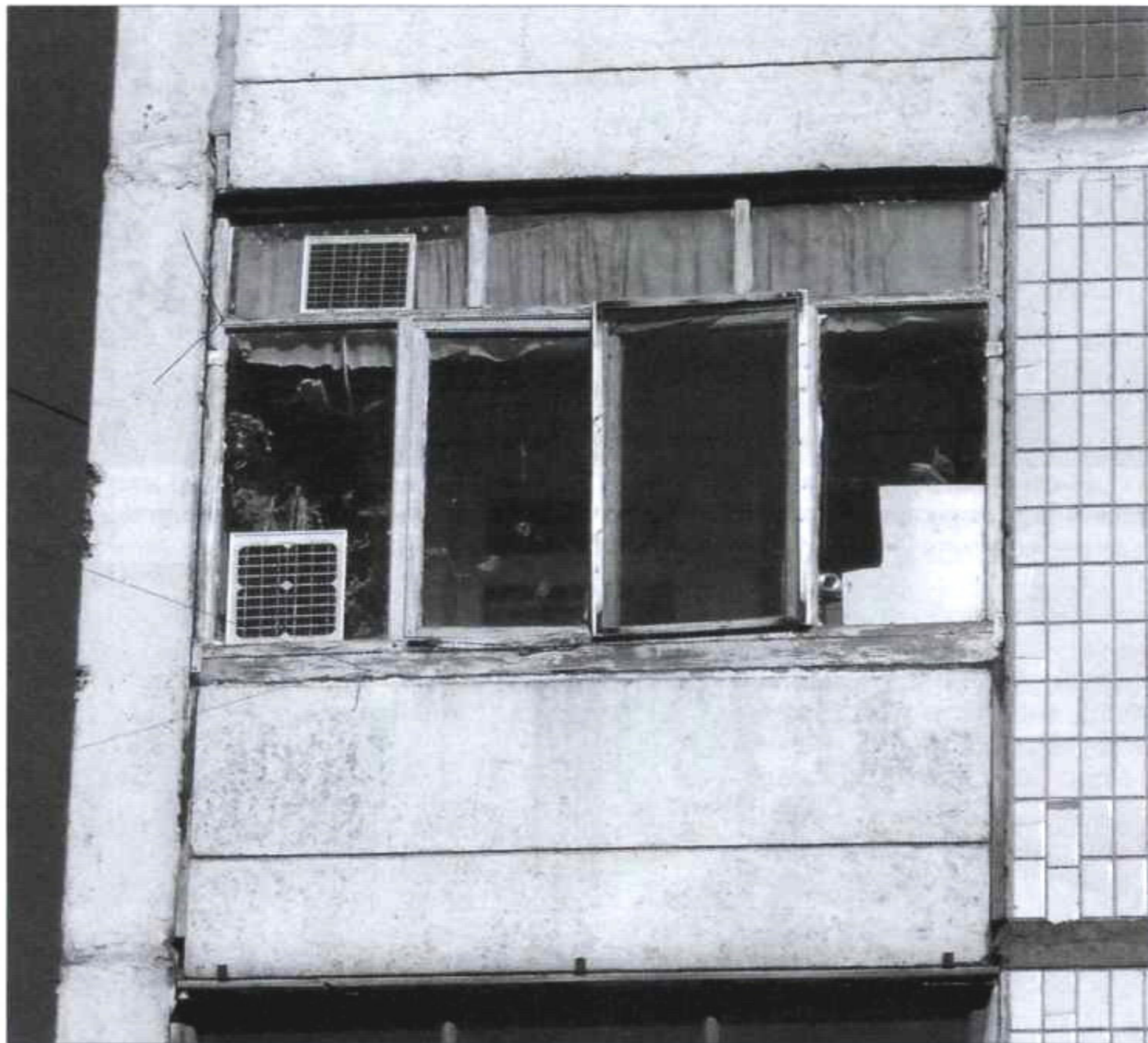
Фото 2. Солнечные батареи на балконе многоэтажного дома
