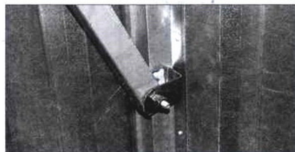
Кронштейн шарнирного крепления рычага к воротам
