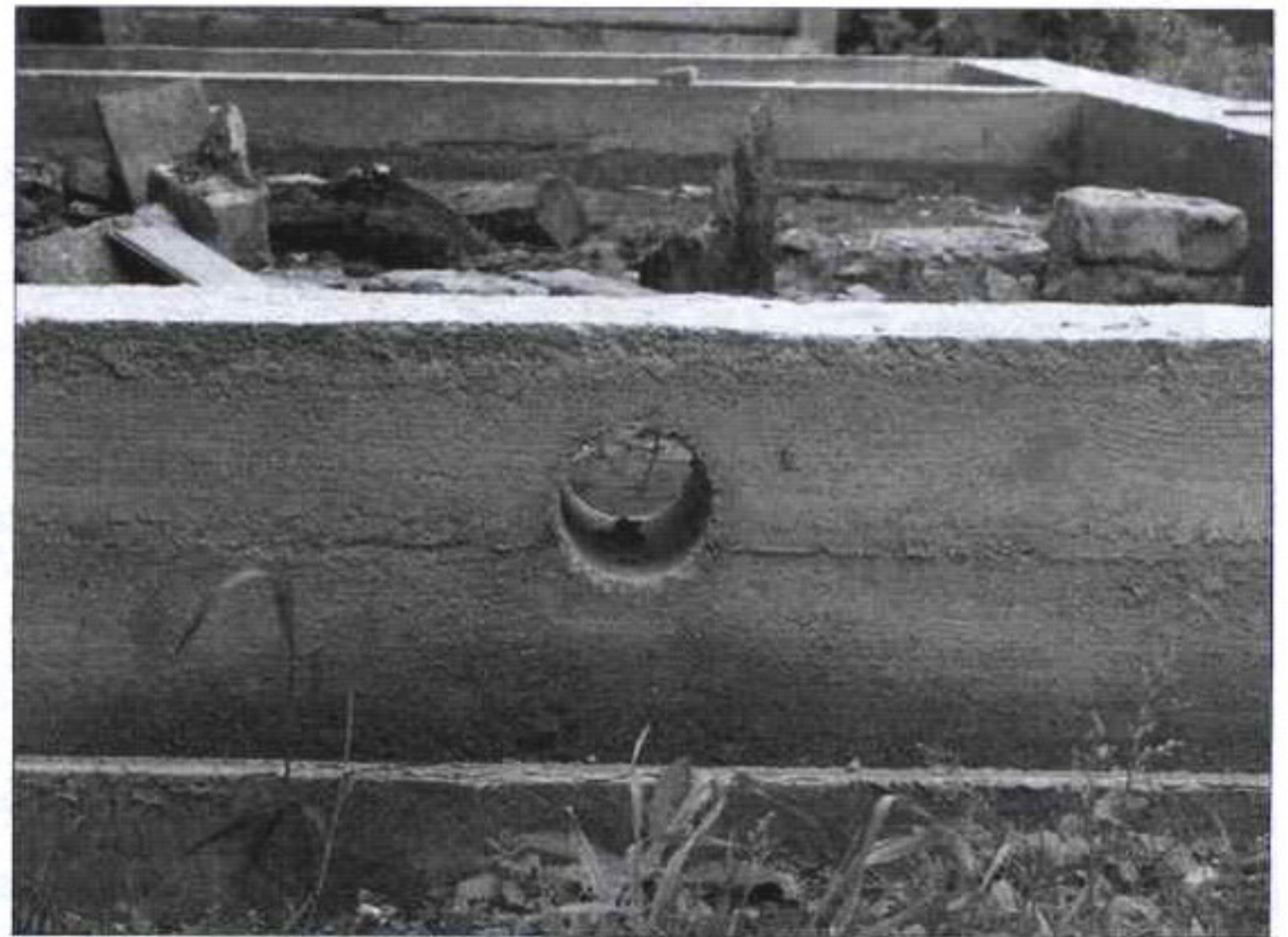
Вентиляционное отверстие
