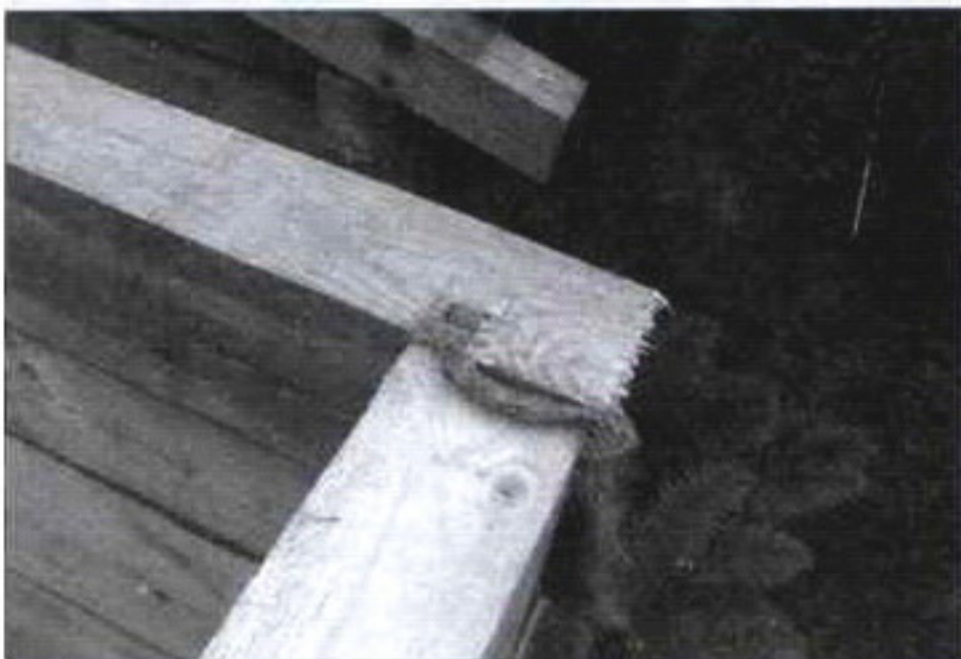
Стык брусьев боковой и фасадной стен
