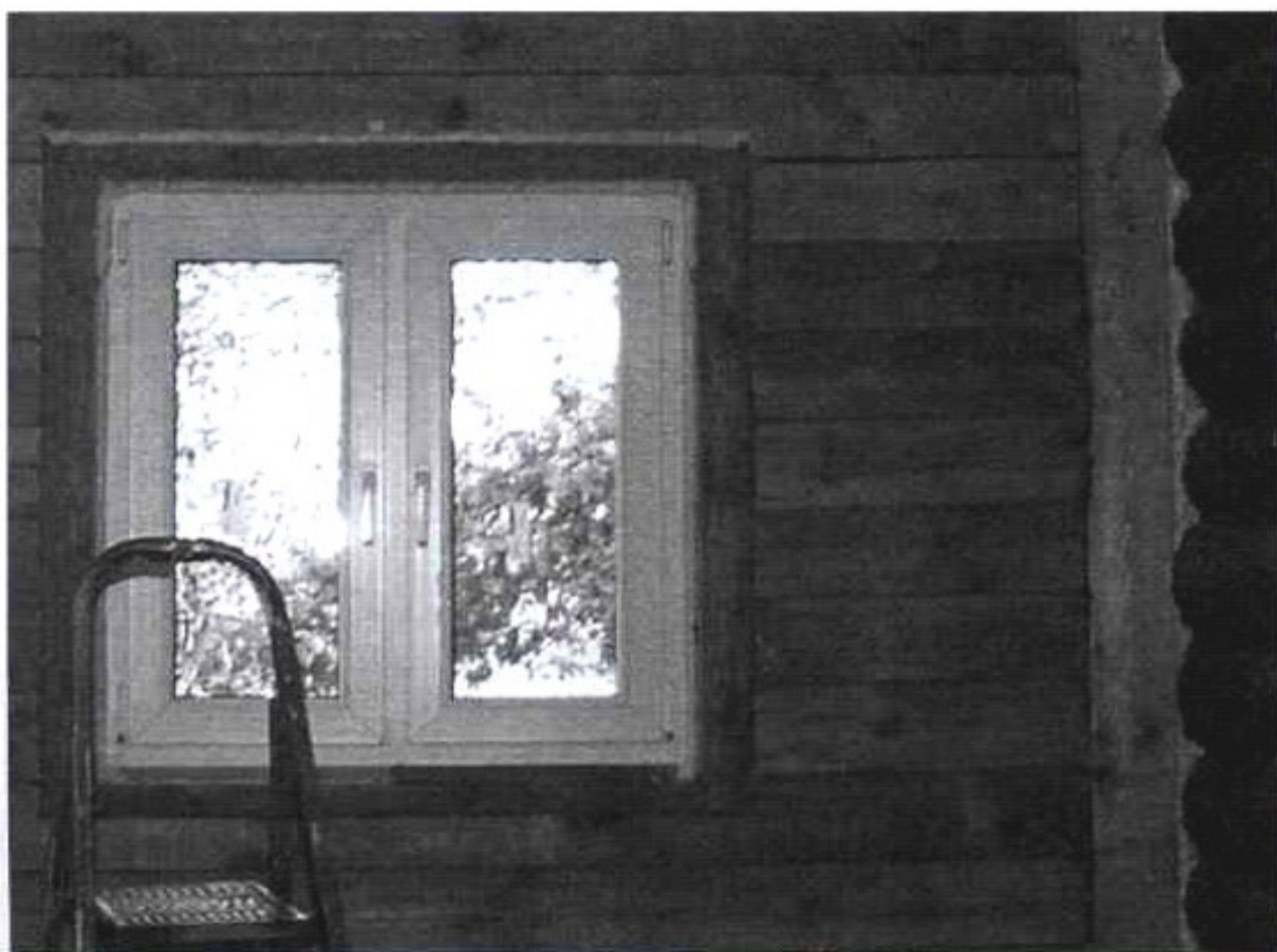
Стык между бревнами сруба и стеной веранды заделан монтажной пеной
