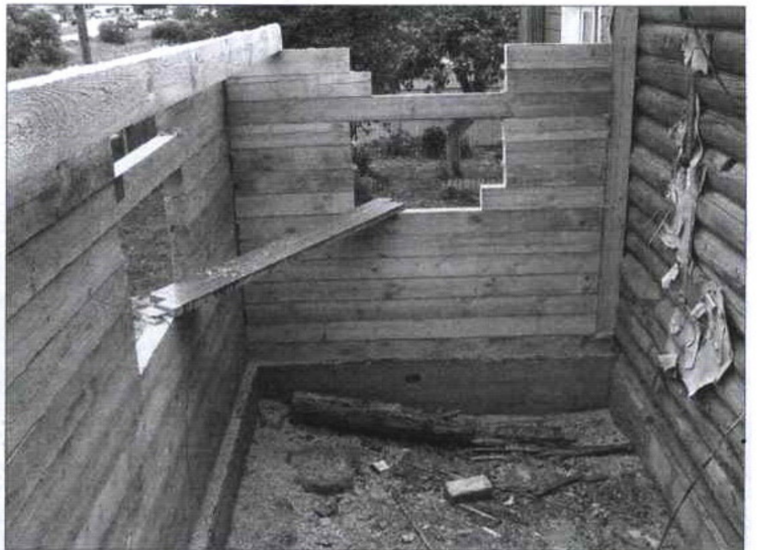
Возведение стен веранды с проемами для окон
