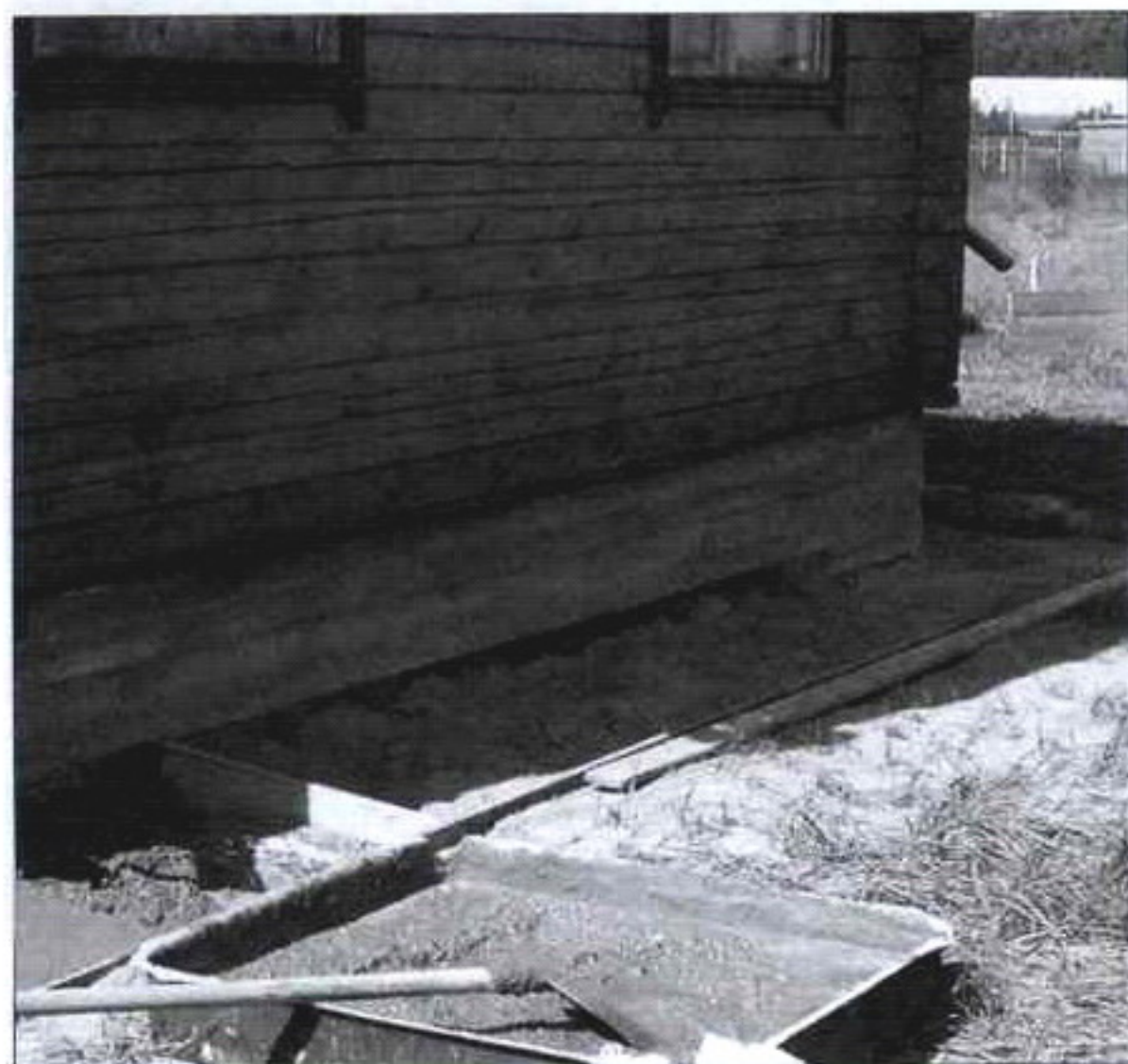
Устройство песчаного подстилающего слоя в траншее
