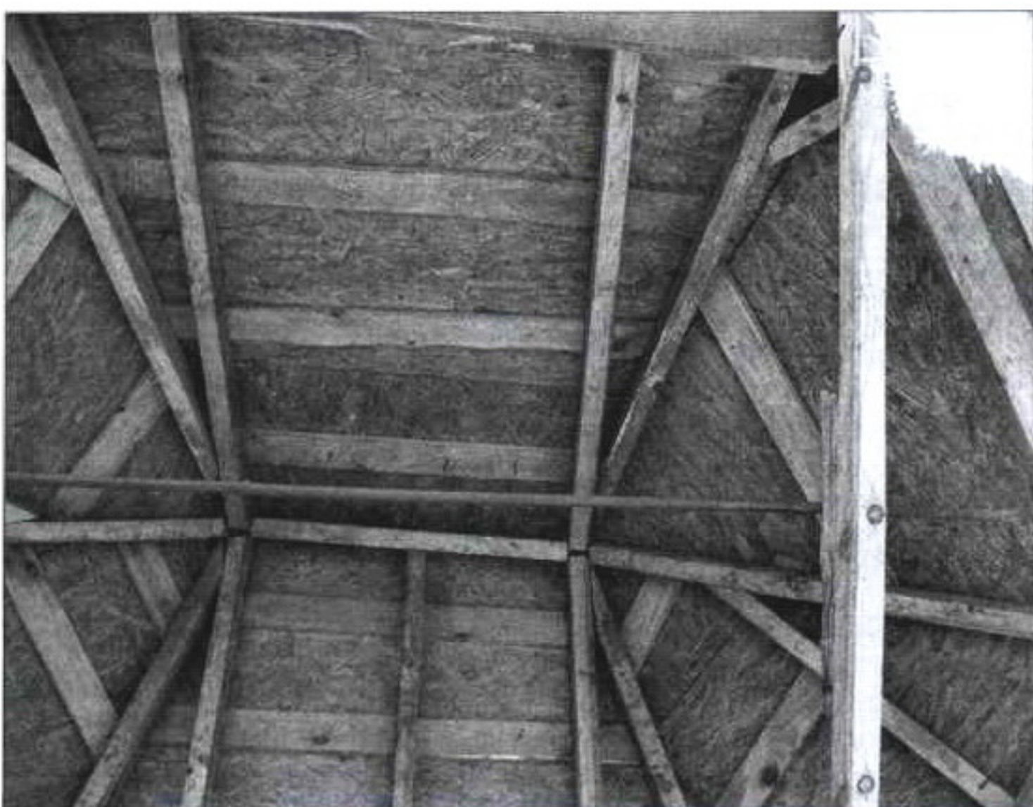
Каркас крыши. Вид снизу
