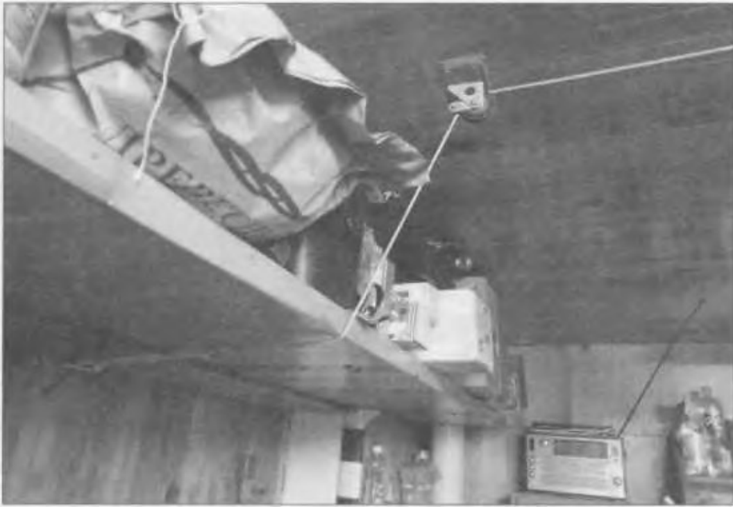
Фиксация коуша посредством веревочной петли на крюке стены
