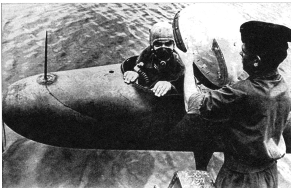
Механик помогает закрыть купол торпеды Neger. Хорошо виден штырь, приваренный в качестве прицела
