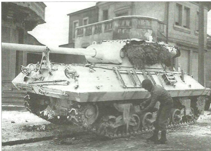
Обслуживание экипажем ходовой части
