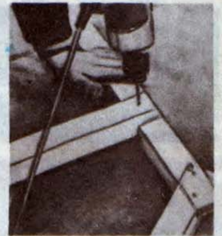
Сборка каркаса стены.
