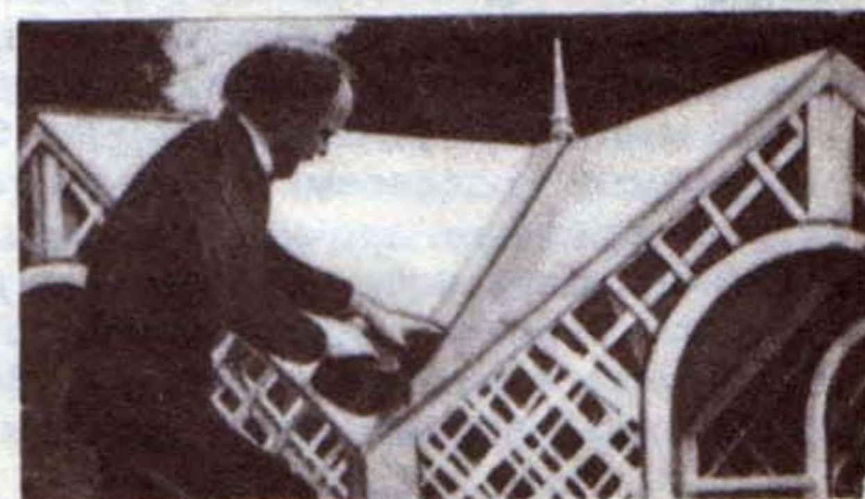
Герметизация стыка панелей крыши приклеиванием рубероидной ленты.
