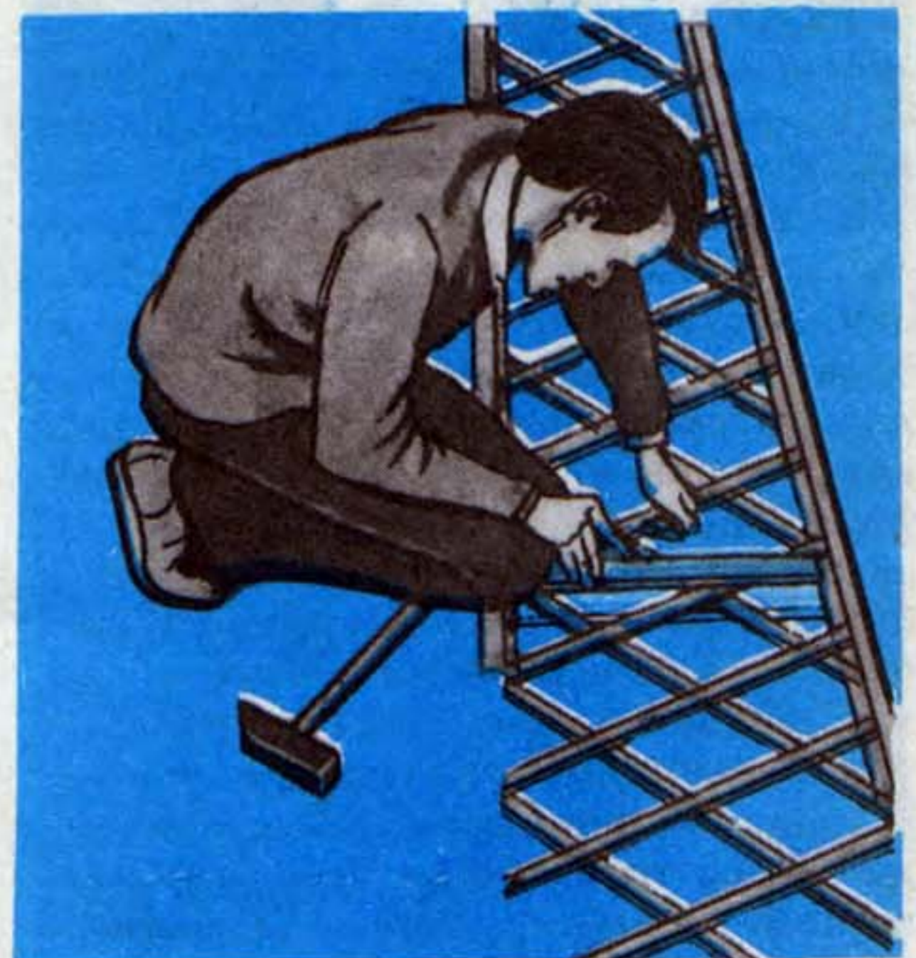
Монтаж предварительно собранной деревянной решетки на каркасе панели.
