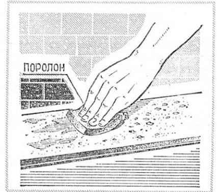
и нанести его тонким слоем на предварительно смоченную поверхность. Затем, увлажнив кусок поролона, удалить им излишки цемента. После высыхания раствора плоскость будет ровной, без единой трещины и раковины.
