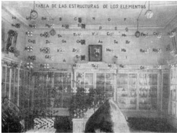
*Figura 1.2 Estructuras cristalinas de los elementos químicos dispuestos en las casillas correspondientes de la tabla de Mendeléev. La colocación de las bolitas, muestra cómo se distribuyen los átomos en el cuerpo sólido simple. En primer plano, a la izquierda, se ve el esquema de la distribución de los átomos de silicio y de oxígeno en el cuarzo. (Exposición en el Museo del Instituto de Minas de Leningrado.)*
