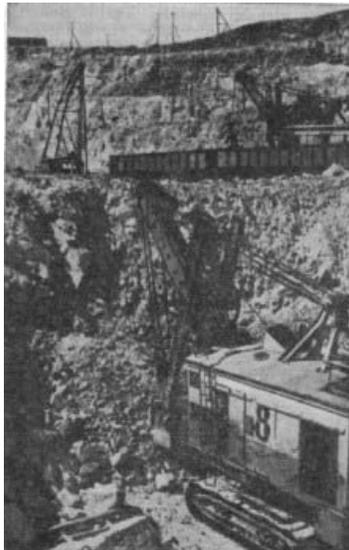
*Figura 33.9 Extracción de mineral por medio de excavadoras*
