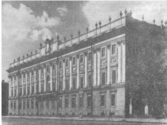
*Figura 14.7 Palacio de Mármol de la filial del Museo de V. I. Lenin en Leningrado. A excepción del piso bajo (construido de granito), todo es de mármol ruso*
