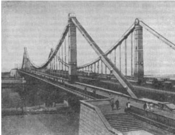
*Figura 33.4 Moscú. Puente de Crimea, construido de duraluminio*
