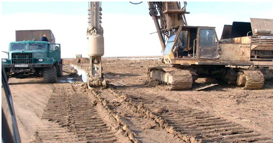
Рисунок 31 - Строительство противофильтрационной завесы (стена в грунте) вокруг прудов испарителей
