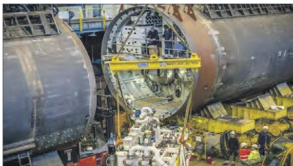
НАПЛ «Готланд» проекта А19. Модернизация в части вооружения с заменой ВНЭУ (2013)
