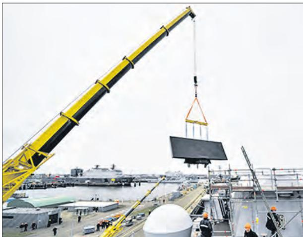
*Монтаж корабельной РЛС SMART-L MM/N на фрегат УРО «Де Зевен Провинсен»*
