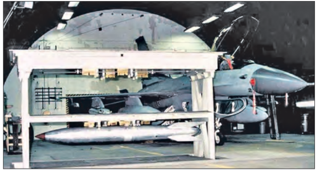
Хранилище системы WS3 в поднятом положении с ядерной авиабомбой B61 (внутри защищенного укрытия для самолетов)
