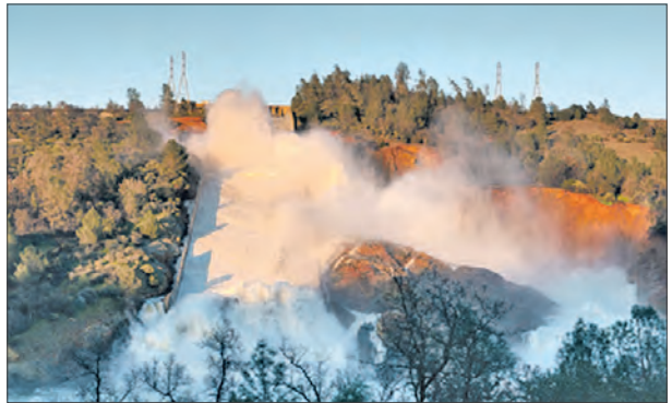
Разрушение плотины в г. Оровил, штат Калифорния (13 февраля 2017 года)
