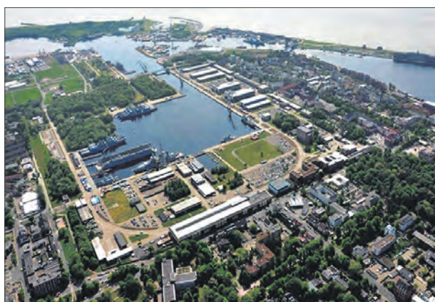
Общий вид военно-морского арсенала федерального ведомства по вооружению и военной технике, информационным технологиям и их применению бундесвером (г. Вильгельмсхафен)
