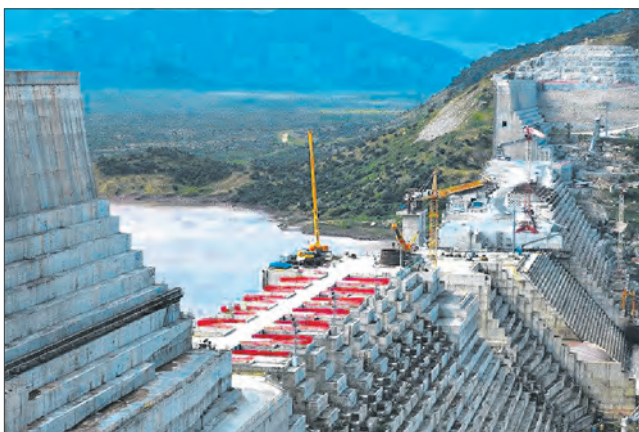
Эфиопская ГЭС «Возрождение» на этапе строительства (май 2021 года)
