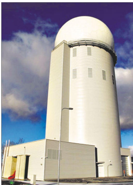
Радиолокационный пост НАТО Дезучай (Шилутский район, Литва), смонтированный на металлической башне высотой 50 м
