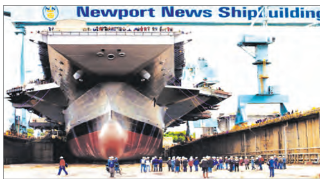
Строительство АВМА на заводе «Ньюпорт-Ньюс шипбилдинг»
