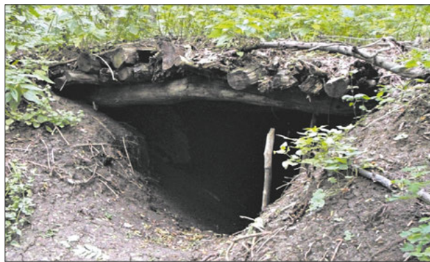
Укрытие в лесу под мостом
