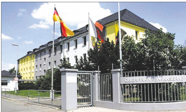
Здание научно-исследовательского центра разведки техническими средствами
