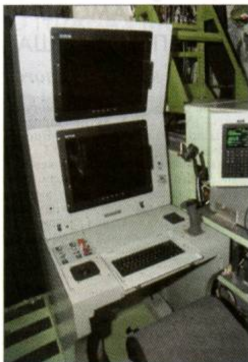
Автоматизированное рабочее место оператора системы управления огнем
