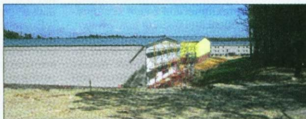
Строительство казармы (вверху) и складских зданий в военном городке Форт-Беннинг
