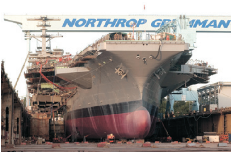
Строительство авианосца на судовой верфи компании «Нортроп-Грумман»
