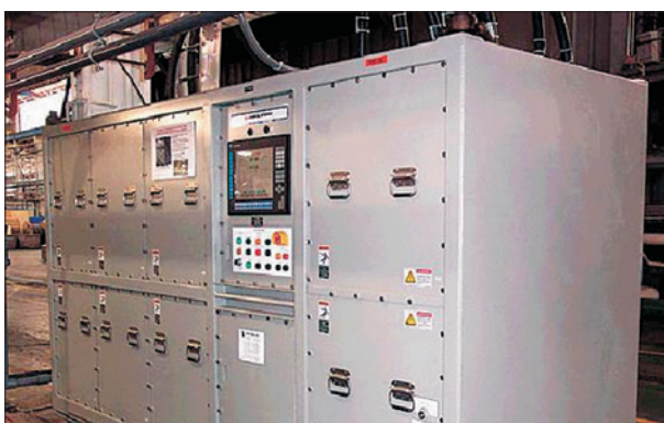
Рис. 2. Модуль PCM-4 преобразователя-выпрямителя переменного тока в постоянный
