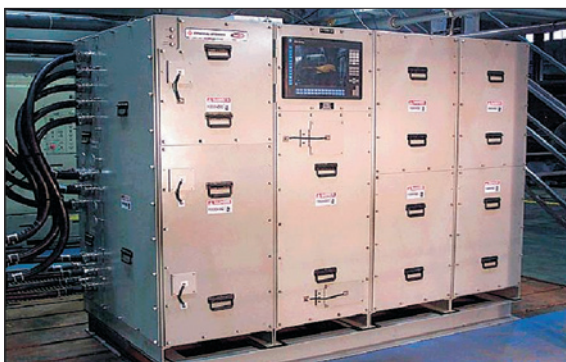
Рис. 4. Модуль РСМ-1 преобразователя постоянного тока с исходными параметрами в постоянный ток необходимых для конкретных потребителей параметров:
