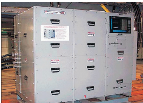
Рис. 3. Модуль РСМ-2 обратного преобразователя постоянного тока в переменный:
