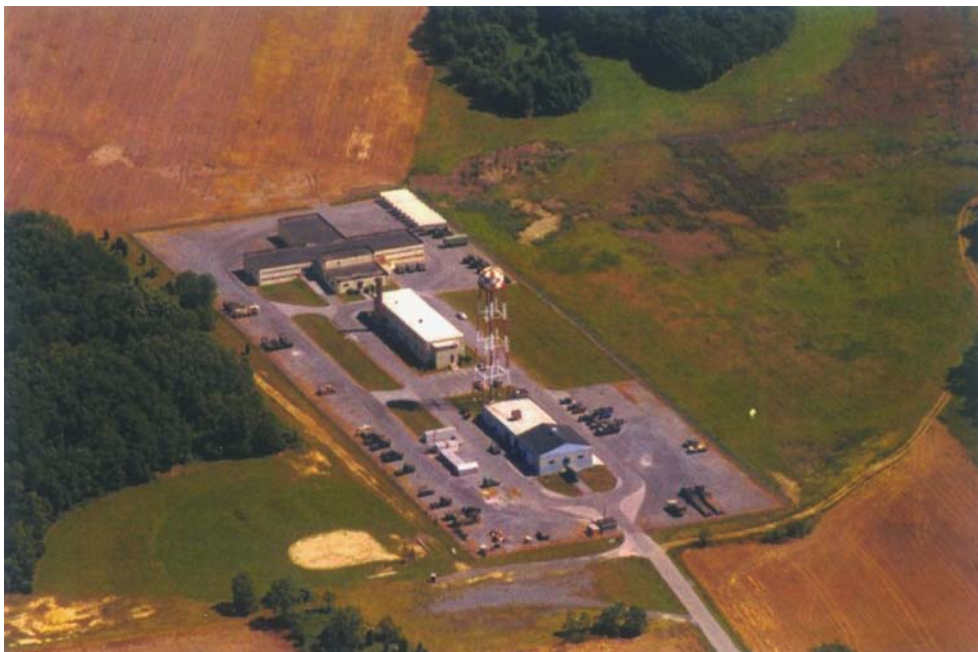
Рис. 7. Комплекс обеспечивающих наземных сооружений ЗКЦ КНШ
