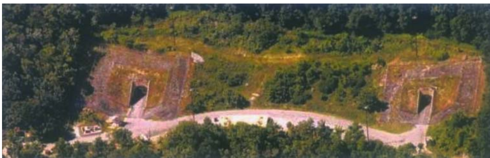
Рис. 6. Входы в подземные сооружения ЗКЦ КНШ
