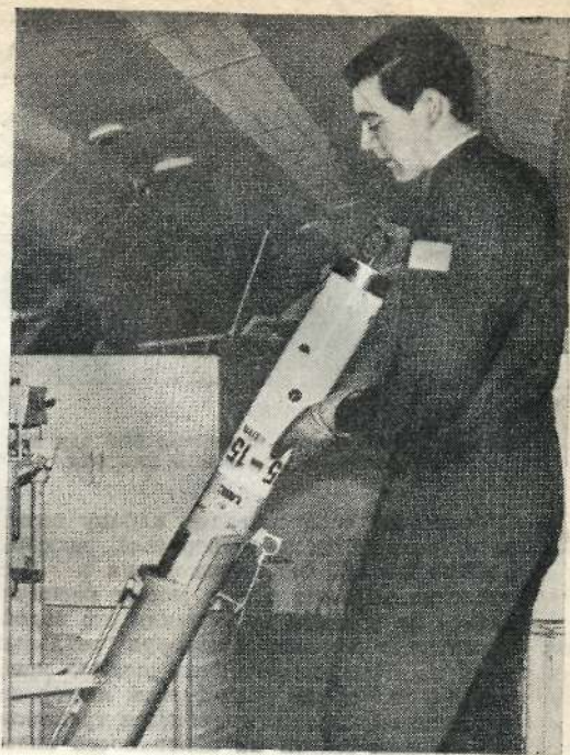
Рис. 2. Установка радиогидроакустического буя в пусковую установку на английском противолодочном самолете «Нимрод»
