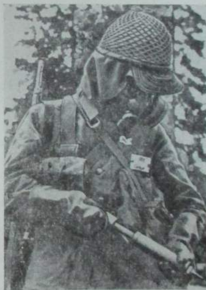
Рис. 2. Обнаружение ОВ в воздухе с помощью шведского газоопределителя.
