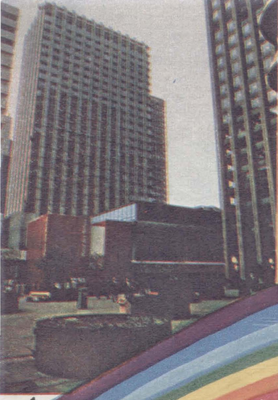
1. Район Дефранс в Париже. Административно-общественный центр. Архитектор Б. Зерфюсс.
