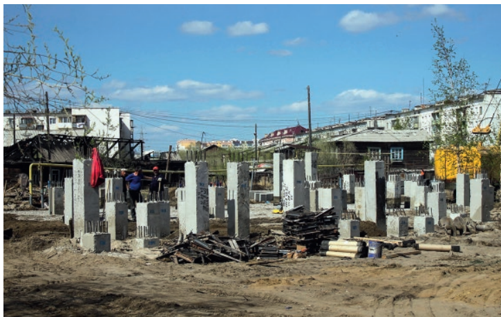
Строительство дома на сваях (Якутск)
