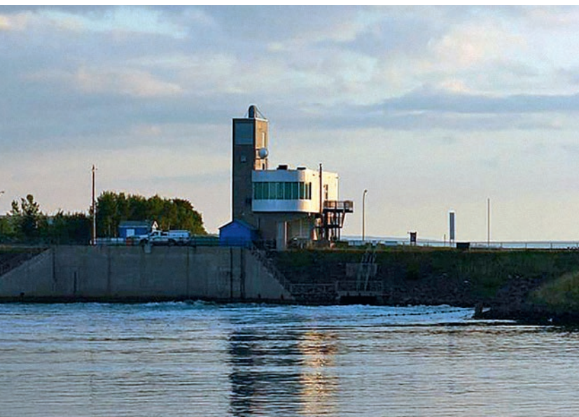
Приливная электростанция в Аннаполис-Ройал, провинция Новая Шотландия, Канада
