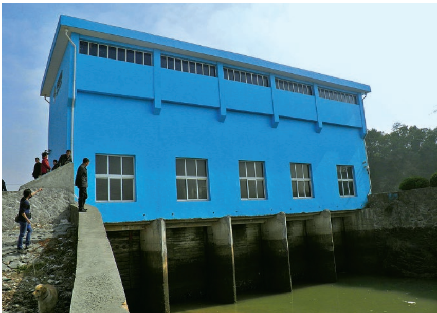
Четвертая по величине приливная электростанция в мире, расположенная в Вэньлине, провинция Чжэцзян, Китай
