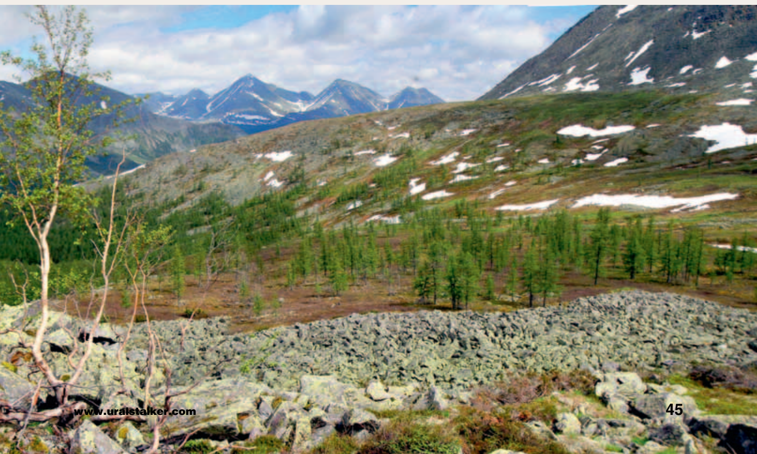
▲ Остатки деревянных столбов ЛЭП
