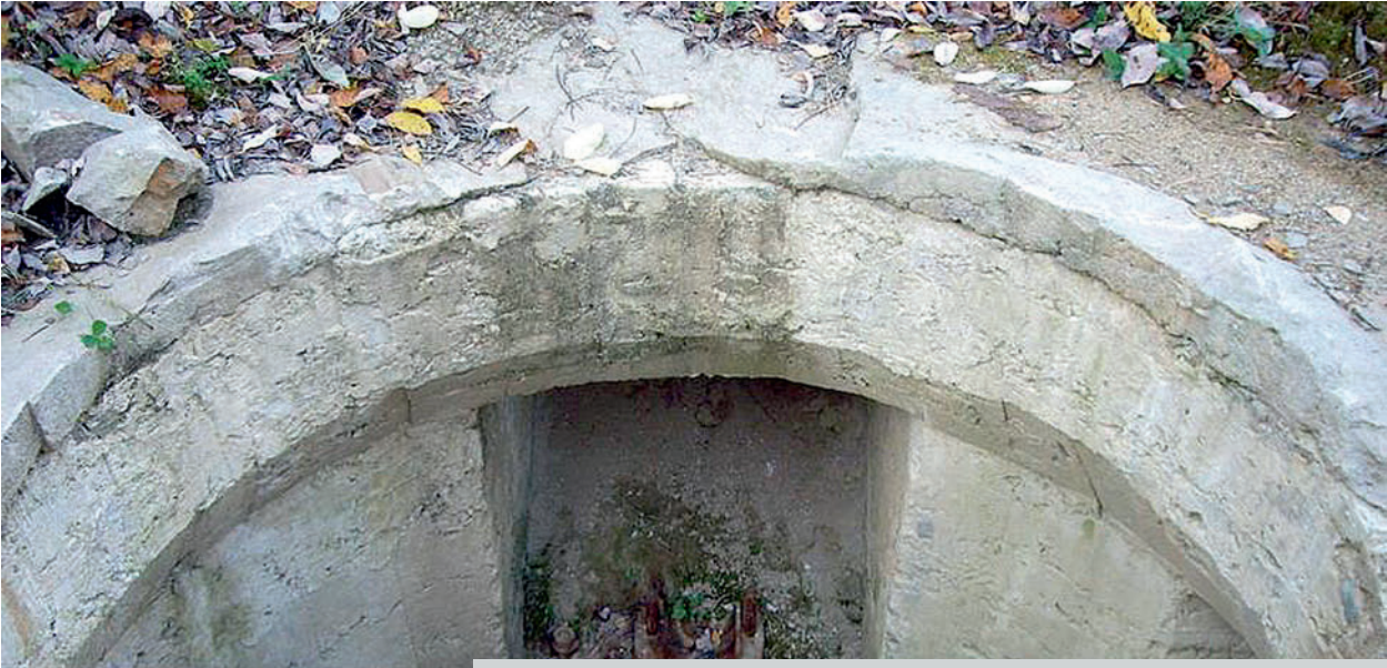
▲ В верхней части снимка виден пояс бетонной подливки
