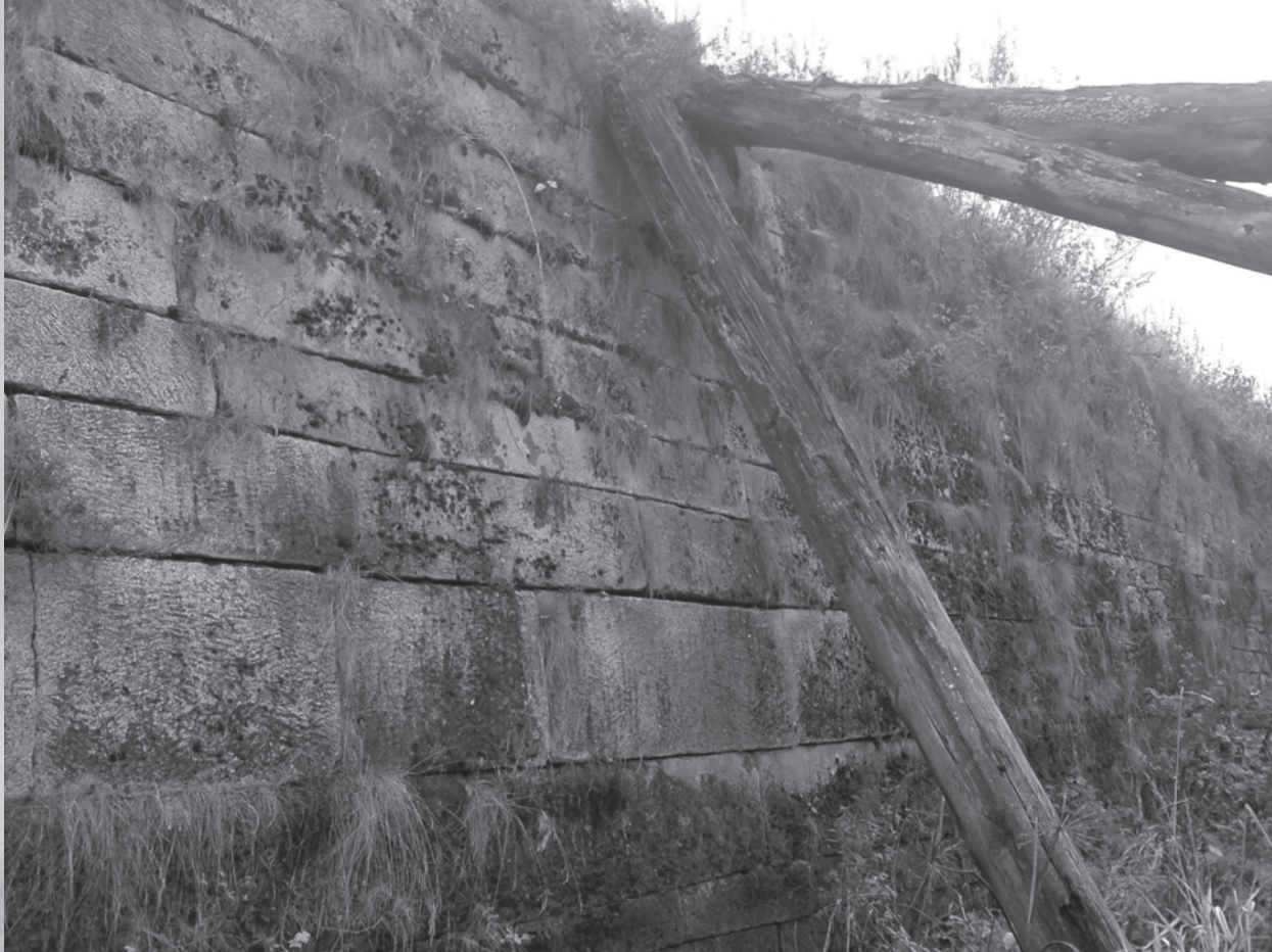
Сохранившаяся стена канала Старо-Шайтанского завода.
