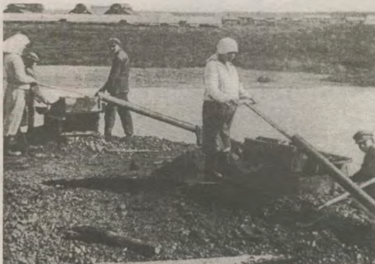
Кустарная добыча золота. Подача воды к станку ручными насосами.
