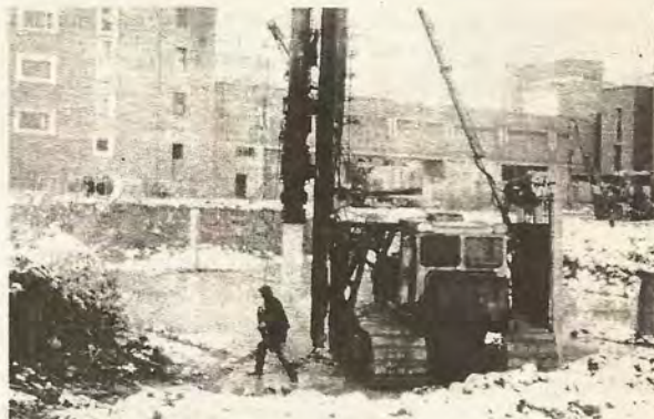
Первые сваи в фундаменте поликлиники.
