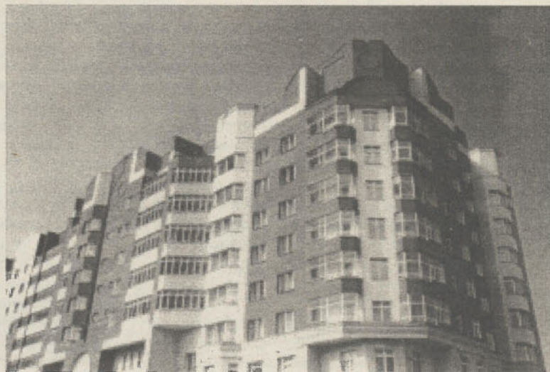
Современный жилой дом в Екатеринбурге.
