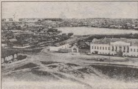
Каслинский чугуноплавильный и железодельный завод. Вид на фабрику. 1899 г. Фото В.Л. Метенкова
