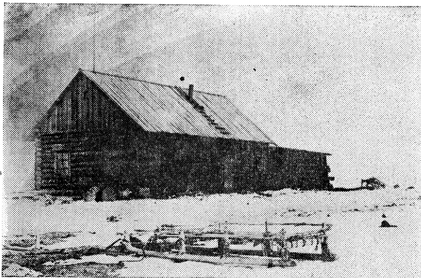
Первый жилой дом в Норильске (ныне Горная ул., 1). 1921 г.
