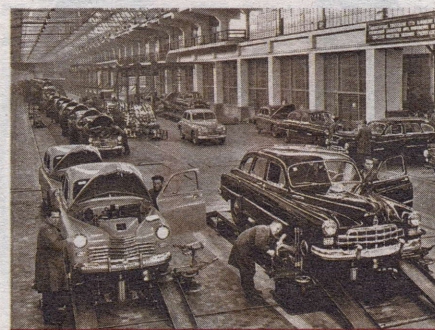
Цех сборки легковых автомобилей Победа и ЗИМ на Горьковском автомобильном заводе
